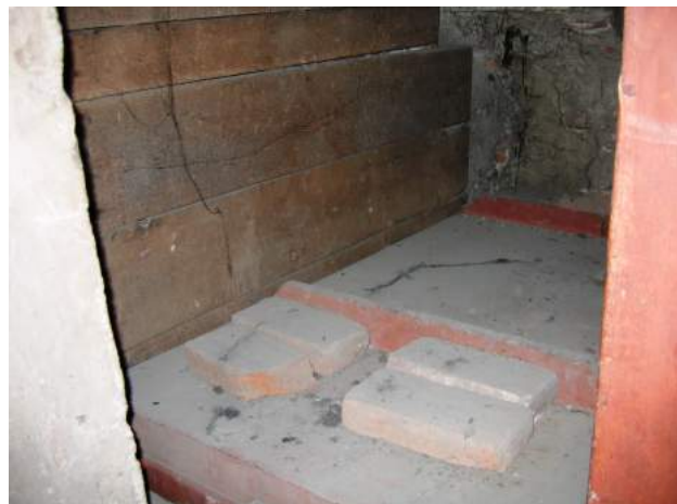
Vista della manteceria prima del restauro
