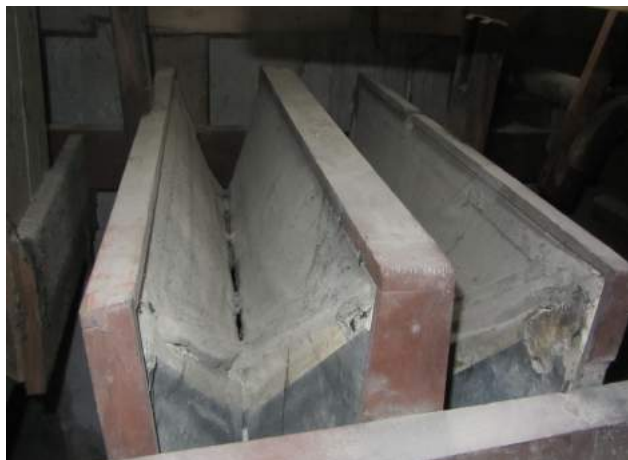
Manteceria prima del restauro
